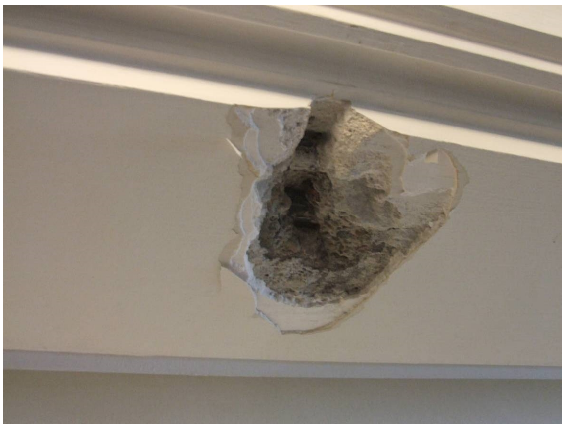
Fot. 19 - odkrywka zbrojenia żebra stropu S1
