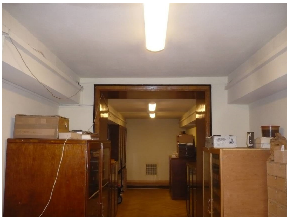
fot.8. Widok spodu stropu widoczne równoległe do belek ściany murowane wykonane w okresie późniejszym
