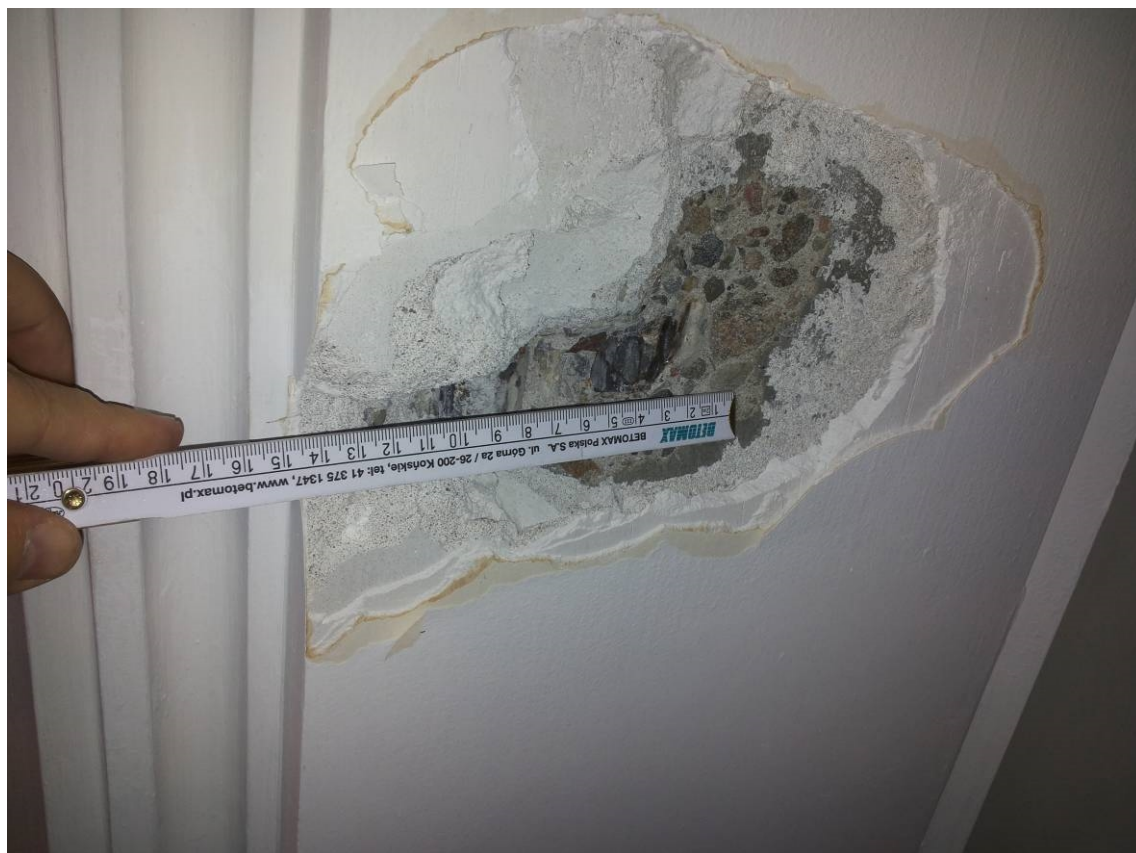
Fot. 18 - odkrywka zbrojenia żebra stropu S1
