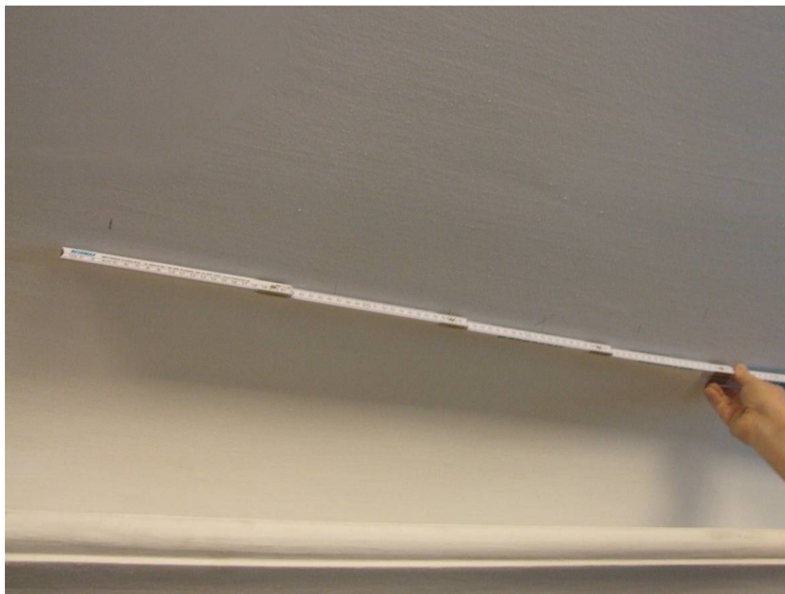
Fot. 20 - oznaczone zbrojenie dole płyty, przy żebrze, w stropie S1
