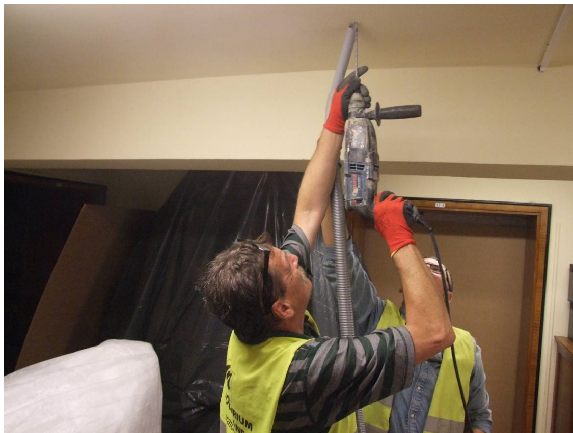
Fot. 30 - Wiercenie stropu S3
