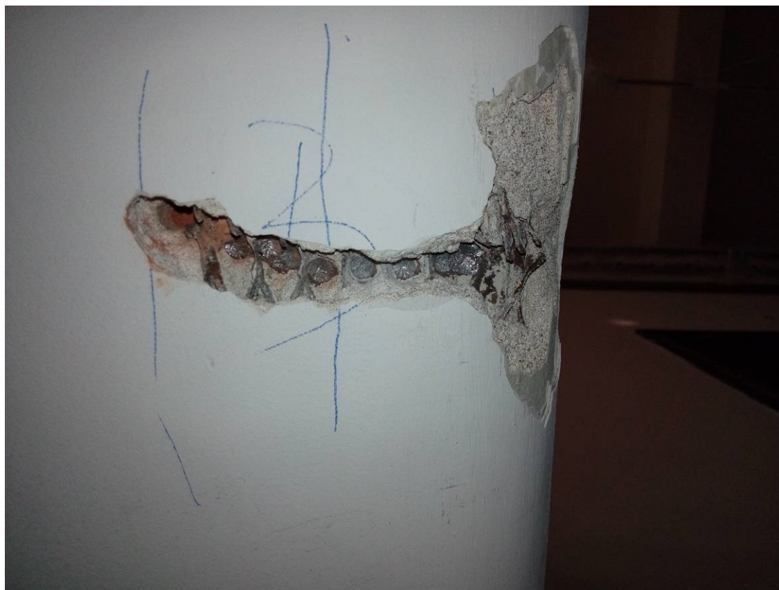
Fot. 24 - odkrywka belki dwuteowej stropu S2 (antresoli). Strop Kleina
