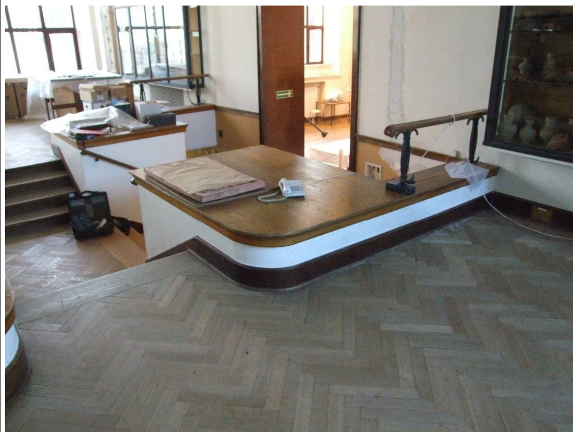
Fot. 23 - wierzch stropu S2 z widocznym cokółem przy schodach. Strop Kleina
