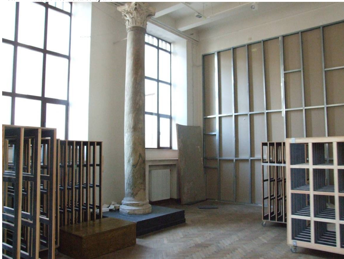
Fot. 13 - wierzch stropu S1 z widoczną tymczasową ścianką działową. Strop żelbetowy żebrowy
